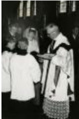
Huwelijk Moens-Boone (III), 1964 (PrCB_015) Object identifier: PrCB_015 Naam: Huwelijk Moens-Boone (III), 1964
