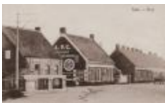
Beke brug (prMPa_006) Object identifier: prMPa_006 Naam: Beke brug
