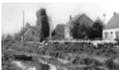
Foto van een herder met schapen op de Cathbrug (HKDVW_102) Object identifier: HKDVW_102 Naam: Foto van een herder met schapen op de Cathbrug
