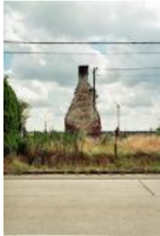
Steun in verlichting, Zandeken (CEVD_008)
