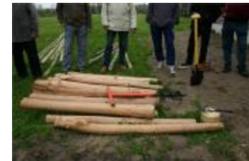
Stap 3 - Aanleg buitenbolbaan: aanbrengen van de denders (PLC_003)
