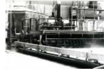
Filterinstallatie, Kuhlmann, 1985-2009 (PrLM_030)
