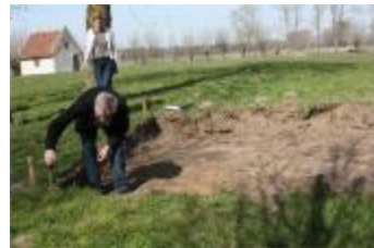
Stap 1 - Aanleg buitenbolbaan: uitmeten van het speelvak (PLC_001)
