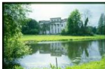
Kasteel Gavergracht, voorgevel 2014 (CV_0110)
