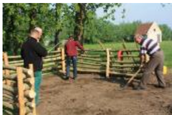
Stap 4 - Aanleg buitenbolbaan: de ondergrond aantrillen (PLC_004)
