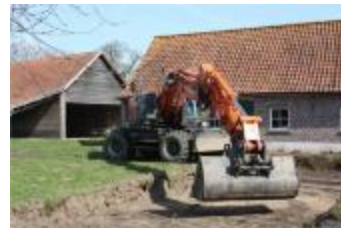
Stap 2 - Aanleg buitenbolbaan: uitgraven van het speelvak (PLC_002)
