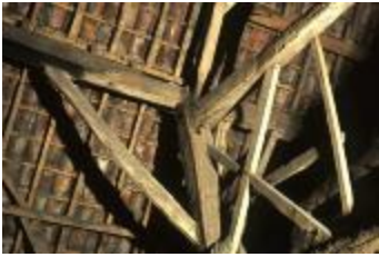
Binnenkant schuur Huysmanhoeve (PrLDS_005)
