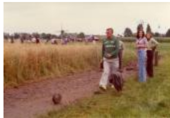
Aanleg buitenkrulbolbanen in het veld (BKB_0033)
