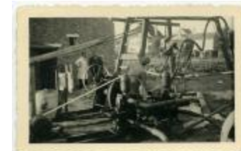
Bouwwerken bij de oprichting van Wasserij Cooreman, 1949, Knesselare (PrPC_072)
