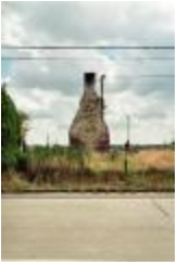
Steun in verlichting, Zandeken (CEVD_008) Object identifier: CEVD_008 Naam: Steun in verlichting, Zandeken
