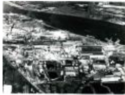
Luchtfoto's Kuhlmannsite, voor 1973 (PrLM_022)
