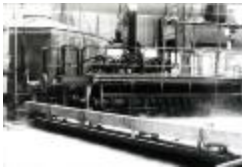
Filterinstallatie, Kuhlmann, 1985-2009 (PrLM_030)
