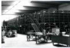
Wisselstukkenmagazijn Kuhlmannsite, 1987 (PrLM_019)
