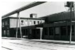
Administratiegebouw Kuhlmannsite, 1987 (PrLM_027)
