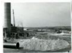
Opbouw Kontakt III, 1970 (PrLM_001)
