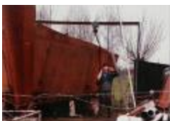
De bouw van de BOU 4 (BOU_012) Object identifier: BOU_012 Naam: De bouw van de BOU 4
