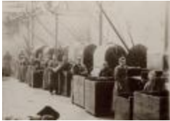
Arbeidsters Haarsnijderijfabriek Enke, ca. 1896 (SPM_011) Object identifier: SPM_011 Naam: Arbeidsters Haarsnijderijfabriek Enke, ca. 1896
