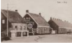
Beke brug (prMPa_006) Object identifier: prMPa_006 Naam: Beke brug
