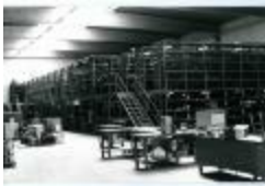
Wisselstukkenmagazijn Kuhlmannsite, 1987 (PrLM_019) Object identifier: PrLM_019 Naam: Wisselstukkenmagazijn Kuhlmannsite, 1987
