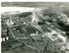
Luchtfoto deel Kuhlmannsite, jaren 1960 (PrLM_017) Object identifier: PrLM_017 Naam: Luchtfoto deel Kuhlmannsite, jaren 1960
