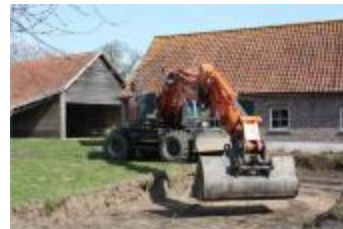
Stap 2 - Aanleg buitenbolbaan: uitgraven van het speelveld (PLC_002)
