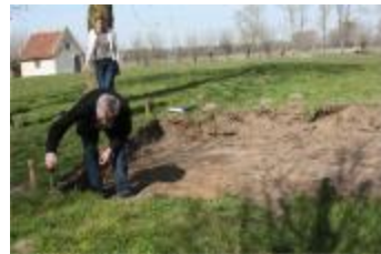
Stap 1 - Aanleg buitenbolbaan: uitmeten van het speelveld (PLC_001)
