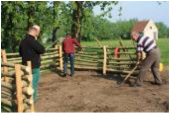
Stap 4 - Aanleg buitenbolbaan: de ondergrond aantrillen (PLC_004)
