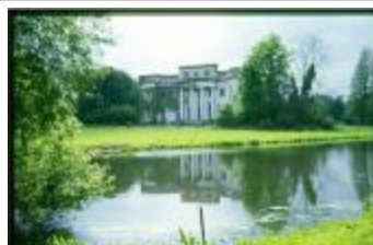
Kasteel Gavergracht, voorgevel 2014 (CV_0110)
