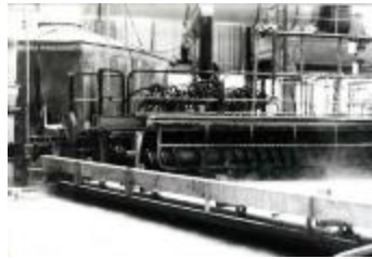
Filterinstallatie, Kuhlmann, 1985-2009 (PrLM_030)
