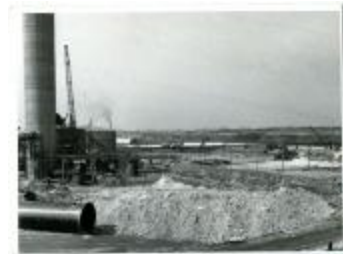
Opbouw Kontakt III, 1970 (PrLM_001)
