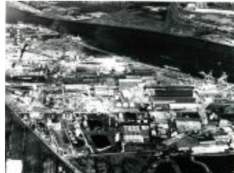
Luchtfoto's Kuhlmannsite, voor 1973 (PrLM_022)
