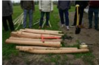
Stap 3 - Aanleg buitenbolbaan: aanbrengen van de denders (PLC_003)
