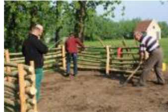
Stap 4 - Aanleg buitenbolbaan: de ondergrond aanrillen (PLC_004)
